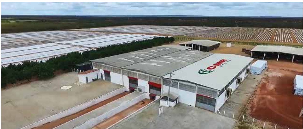
Almacén de CMR en Brasil. Foto facilitada por CMR
